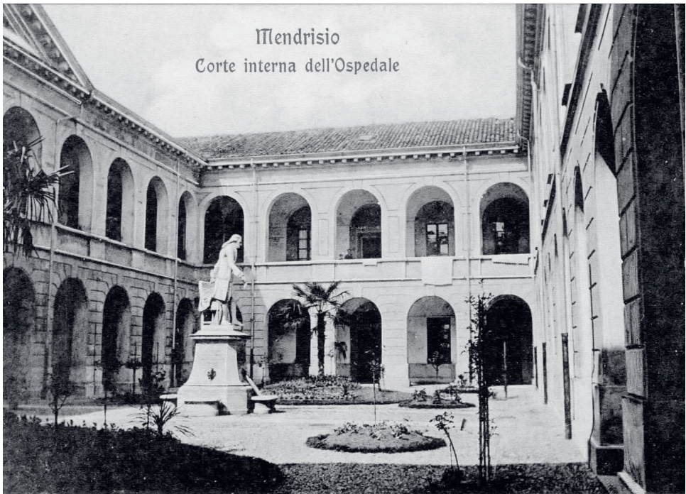
Figura 14. La corte interna dell'OBV.
